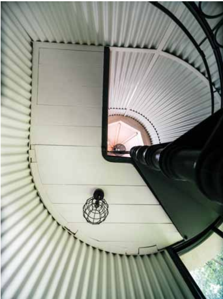
Kruhové schodiště chrání zvenku obezděné a zateplené původní plechové opláštění, které bylo nutné částečně repasovat.
