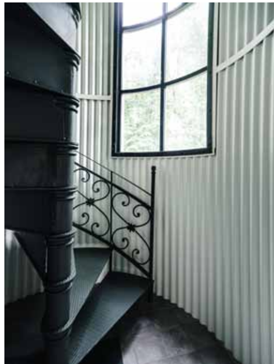
Do patra vede původní litinové schodiště s dekorativním zábradlím.
